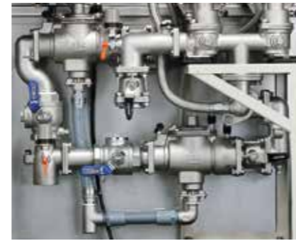
KDP3-W形 逆流防止装置同口径品
